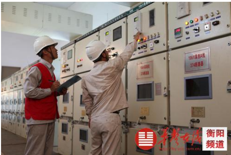
传统中压柜巡检
