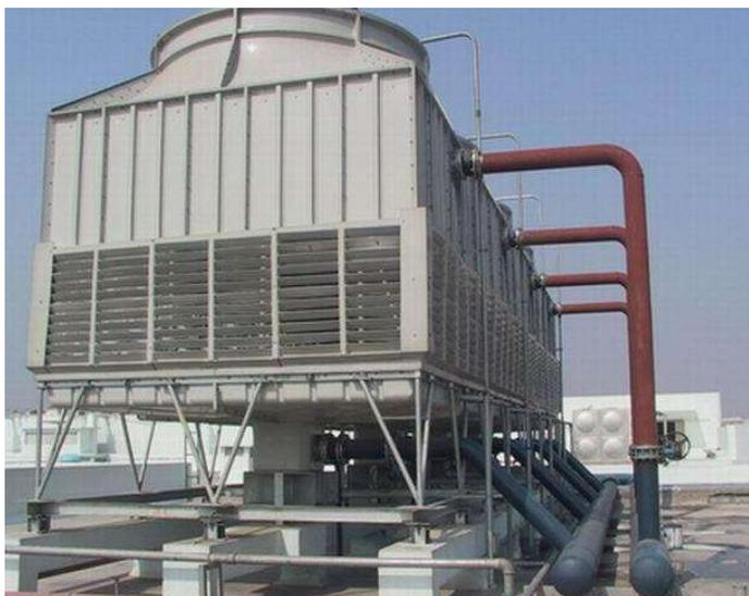
**水机中央空调：**有主机，水泵，冷却塔，末端风机盘管，一般是水冷。
